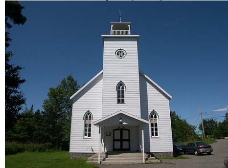
Église en 2003 Vue frontale de la façade principale
