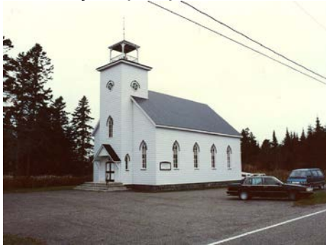
Église en 1990 Vue des façades principale et latérale droite
